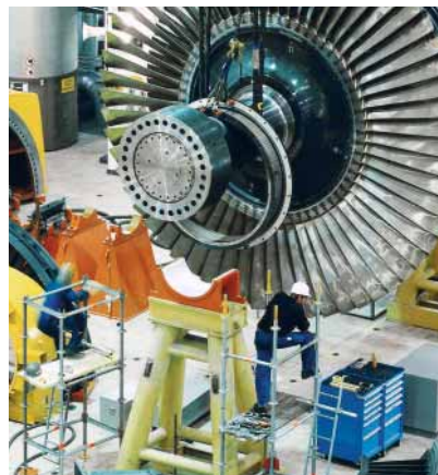
Kernkraftwerk // Niederaichbach (DE)
