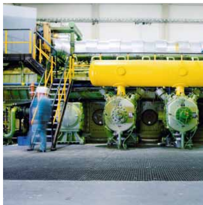
Gaspeicher // Aufgrund der Marktsituation mussten 2008 auch die Gaspreise erhöht werden.
